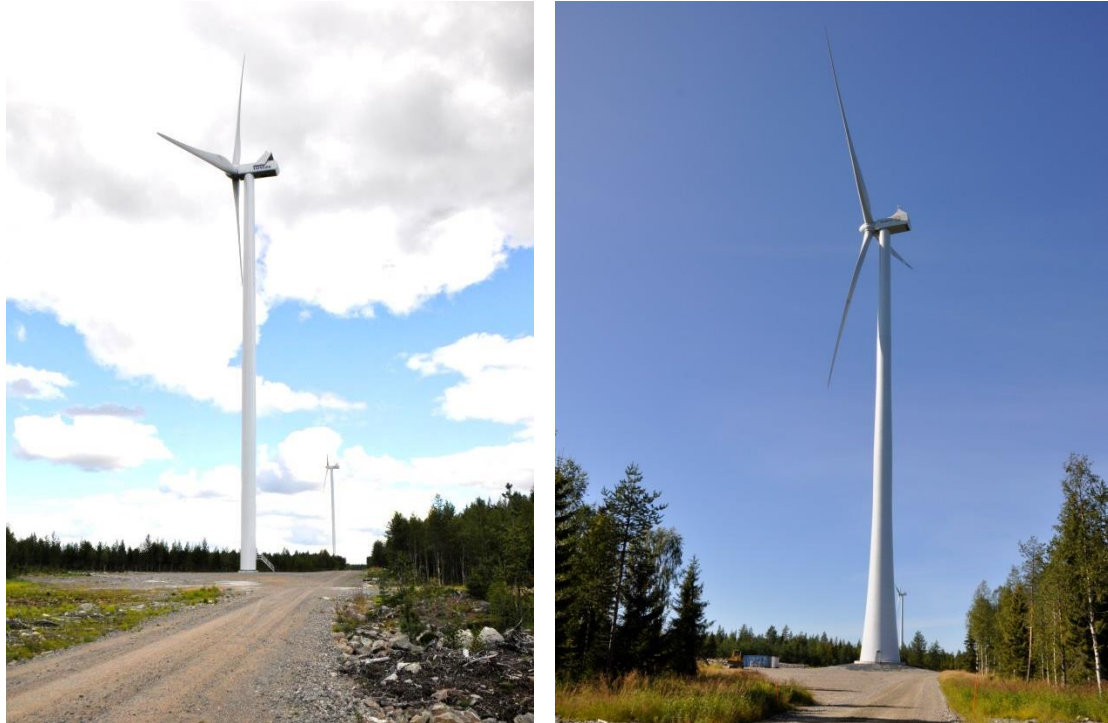
Kuva 13 Esimerkki teräslieriötornista ja oikealla hybriditornista. (Kuvat: Leila Väyrynen, FCG)
