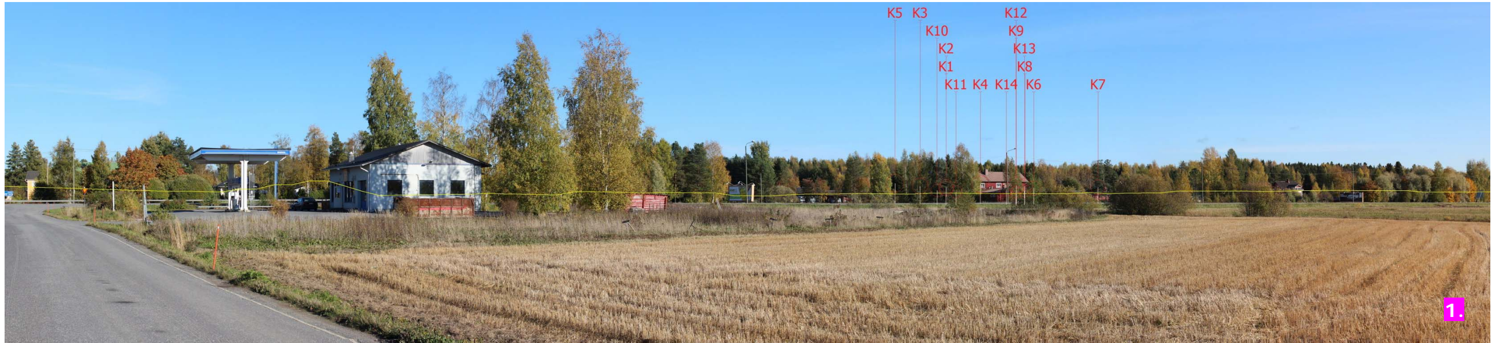
Valokuvasoite 1. Näkymä kohti Kattiharjun voimaloita Isokyläntie 5 kohdalta, etäisyys lähimpään voimalaan noin 8,1 km.
