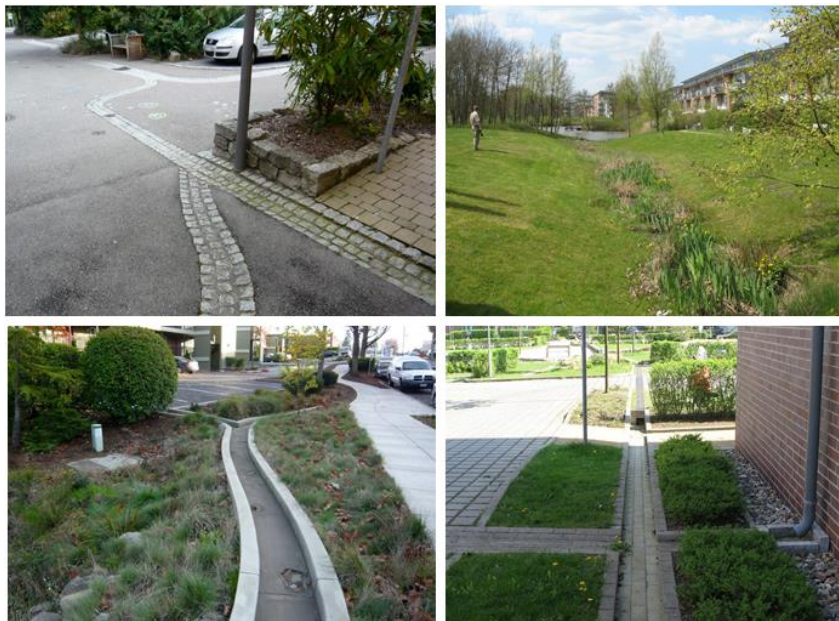
Kuva 7 Esimerkkejä maanpäällisistä hulevesien johtamisratkaisuista
