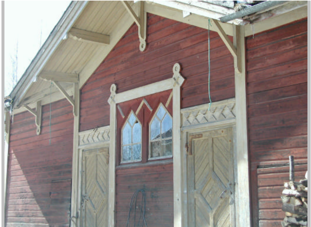
KUVA 4. Vanhan aseman piharakennus.
