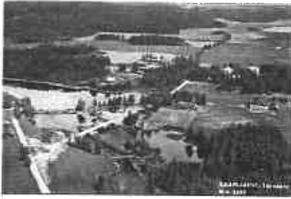
Kuva 1: Ilmakuva Majakoskesta vuodelta 1934. Uusi silta on rakenteilla, vanha silta taustalla. Veljekset Karhumäki
