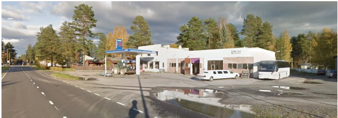
Kuva 17: Huoltomasemarakennus Toivakantieltä (GoogleMaps)
