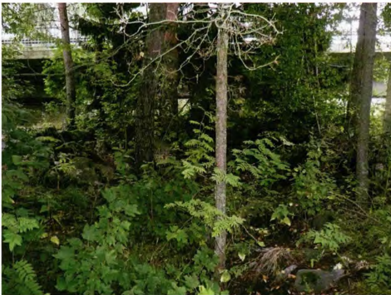
Kuva 28. Saaressa sijaitsevien myllyn rakenteiden kohdalla kasvaa puustoa.
