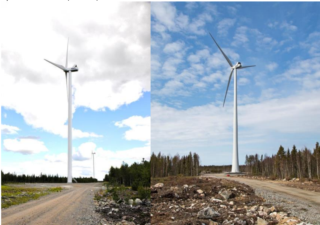
Kuva 71. Vasemmalla on esimerkki teräslieriötornista ja oikealla hybriditornista. (Kuvat: Leila Väyrynen, FCG)
