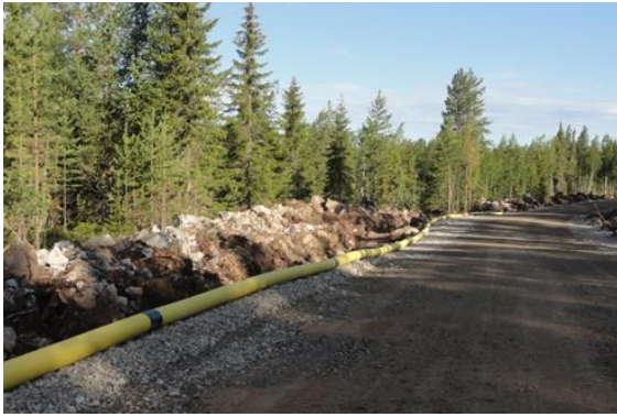
Kuva 76. Vasemmallä: Esimerkki tuulivoimapuiston rakennus- ja huoltotiestä. Maakaapeli sijoitetaan ojakaivantoon tien reuna-alueelle. Oikealla: Tuulivoimalan osia kuljetetaan erikoiskuljetuksina. (Kuvat: FCG).
