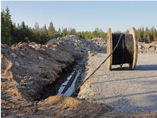
Kuvapari 80. Maakaapelit upotetaan huoltoteiden yhteyteen (Kuvat: FCG).
