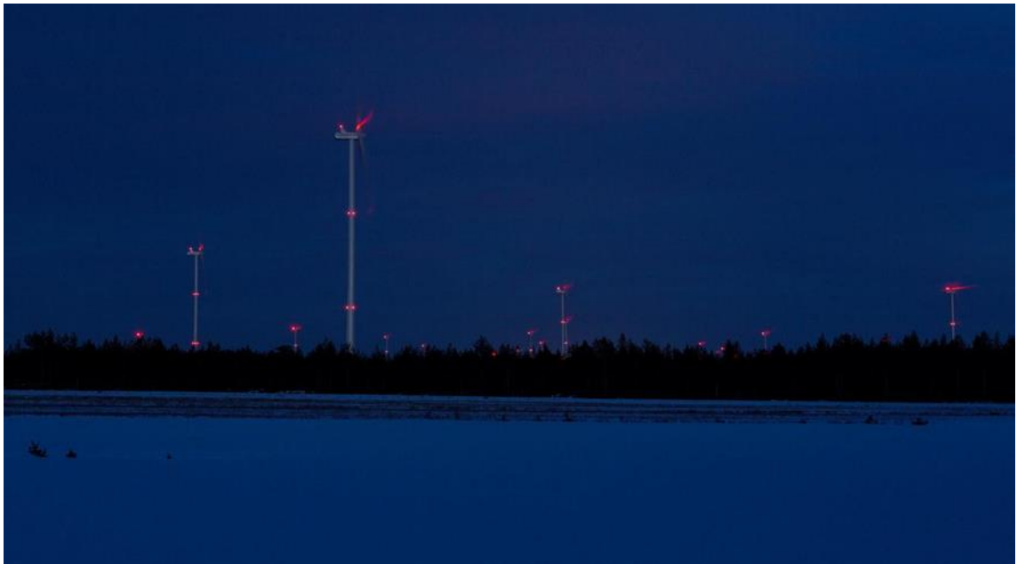
Kuva 73. Kiinteät punaiset lentoestevalot. (Kuva: FCG)
