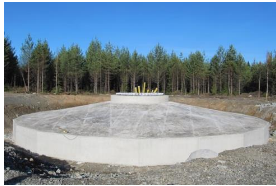
Kuvapari 81. Tuulivoimalan perustusten rakentamista (Kuvat: Leila Väyrynen, FCG).
