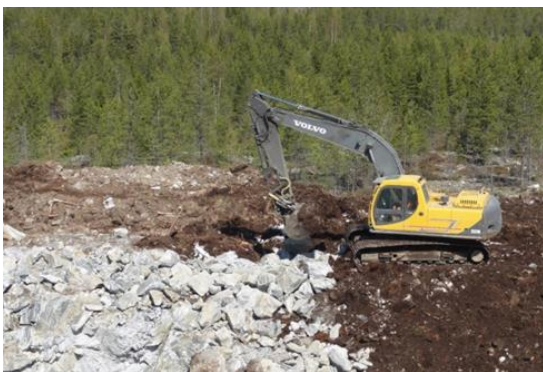
Kuvapari 79. Tuulivoimapuiston rakentaminen alkaa huoltoteiden ja pystytysalueiden rakentamisella (Kuvat: FCG).
