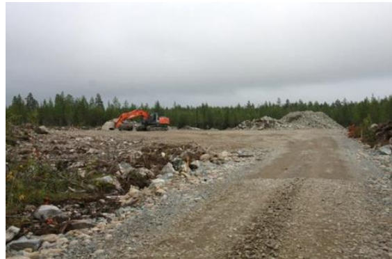
Kuvapari 79. Tuulivoimapuiston rakentaminen alkaa huoltoteiden ja pystytysalueiden rakentamisella (Kuvat: FCG).
