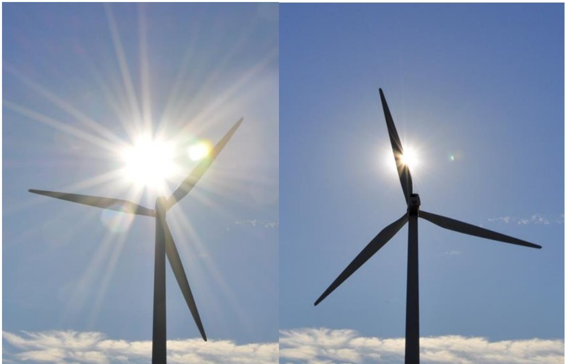
Kuva 58. Tuulivoimaloiden lavat aiheuttavat pyöriessään vilkkumista ja varjon välkkymistä aurinkoisella säällä.
