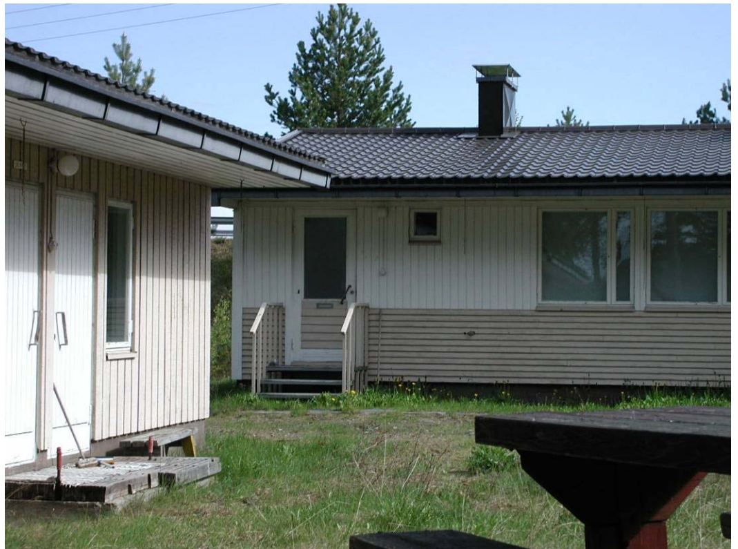
KUVA 7. Saarensalmen sillan kupeessa on tyhjillään entinen lossivahdin talo saunarakennuksineen. Hämeen tiepiiri omistaa rakennukset.
