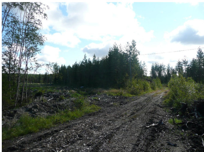
Kuva 4. Voimalapaikalle 6 johtavaa tielinjausta.
