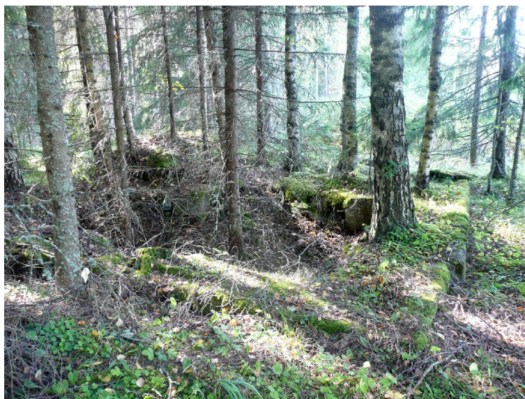
Kuva 9. Rakennuksen perustus tielinjauksen varrella.
