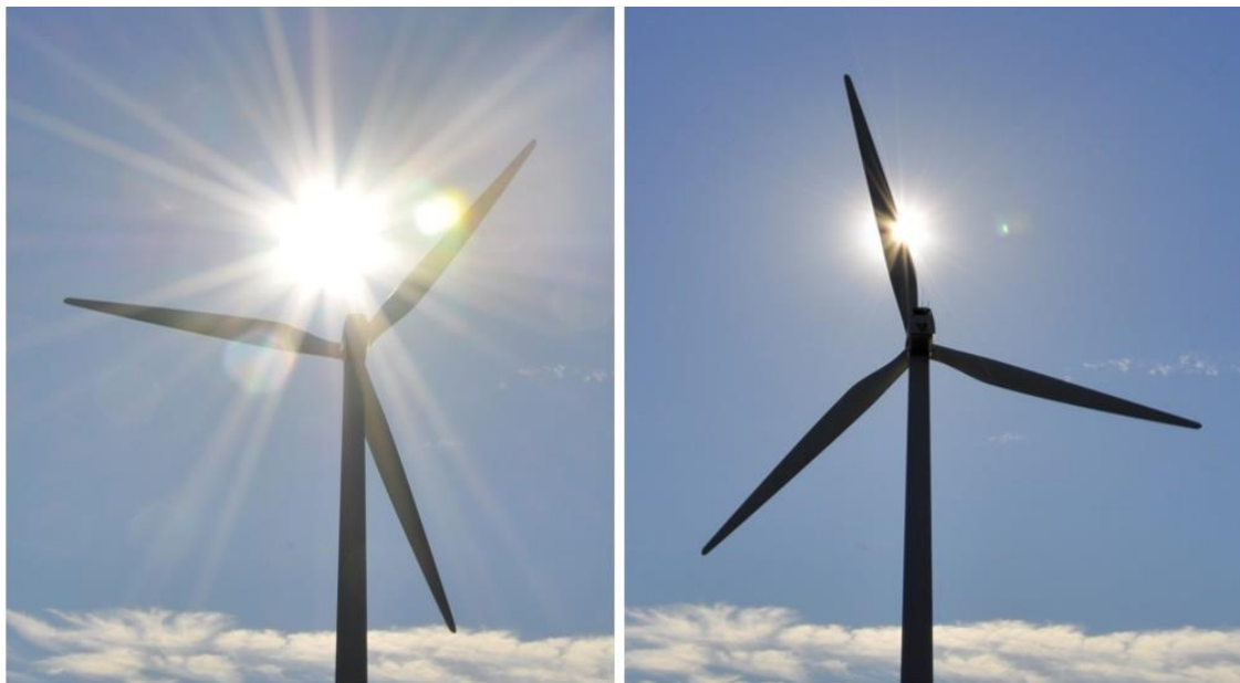
Kuva 42: Tuulivoimaloiden lavat aiheuttavat pyöriessään vilkkumista ja varjon välkkymistä aurinkoisella säällä
