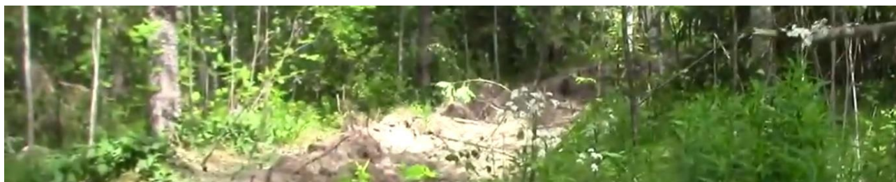
Kuva 13: Tuore kaapelikaivanto ennen maisemointia
