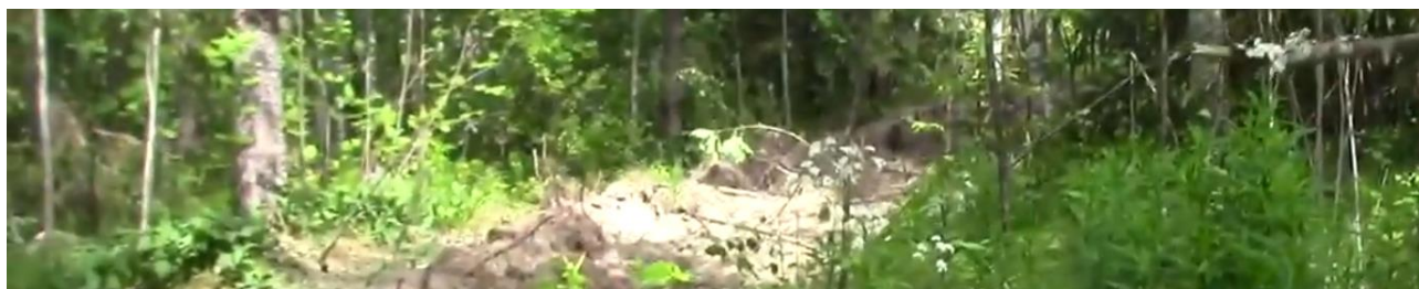
Bild 13: Färskt kabelschakt före anpassningen till landskapet
