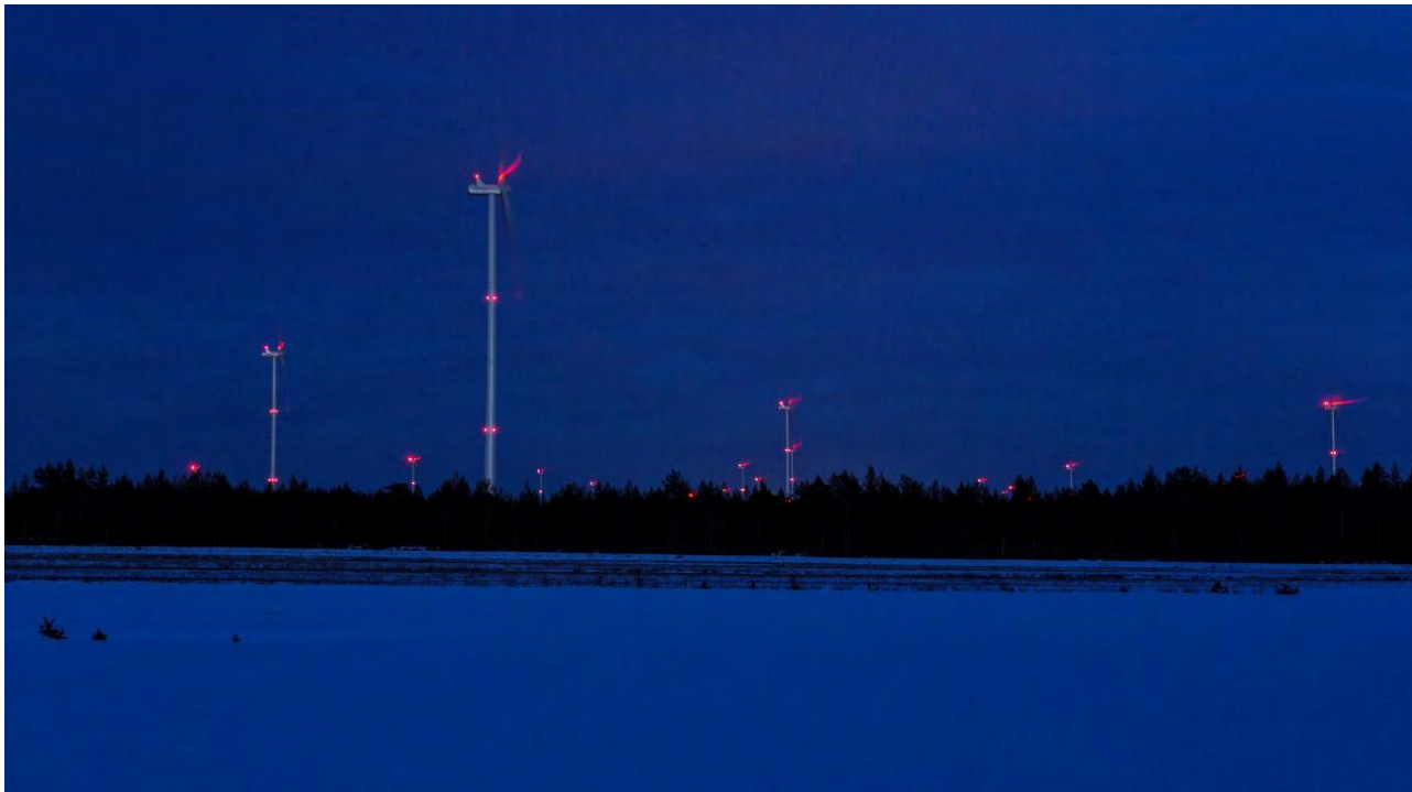
Kuva 43. Kiinteät punaiset lentoestevalot pimeällä (kuva: Ville Suorsa/FCG).
