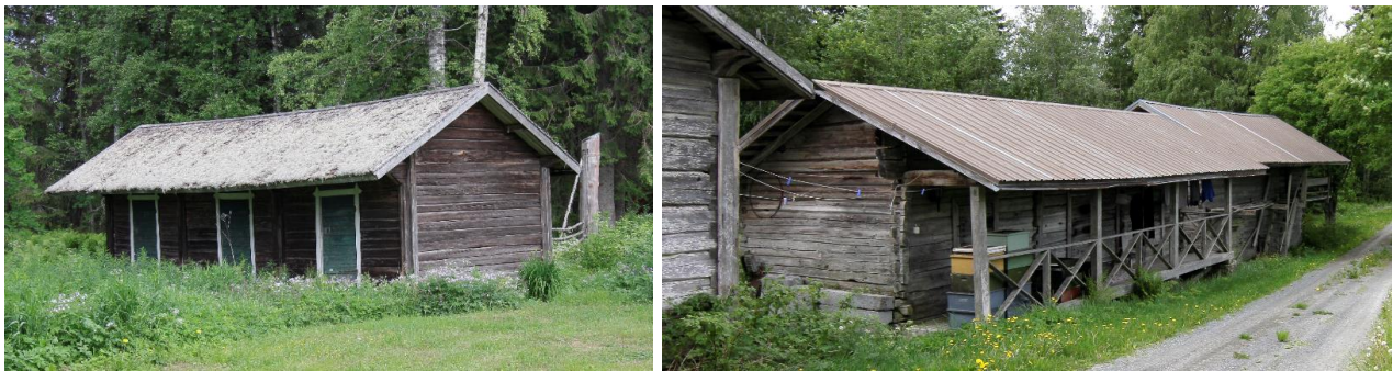
Vasemman puoleisessa kuvassa Reivin aitta 1700-luvulta. Aitassa on edelleen pärekatto. Oikean puoleisessa kuvassa Mannisen avokonkillinen riviaitta 1800-luvulta sekä taaempänä 1700-luvun kaksikerroksinen aitta.
