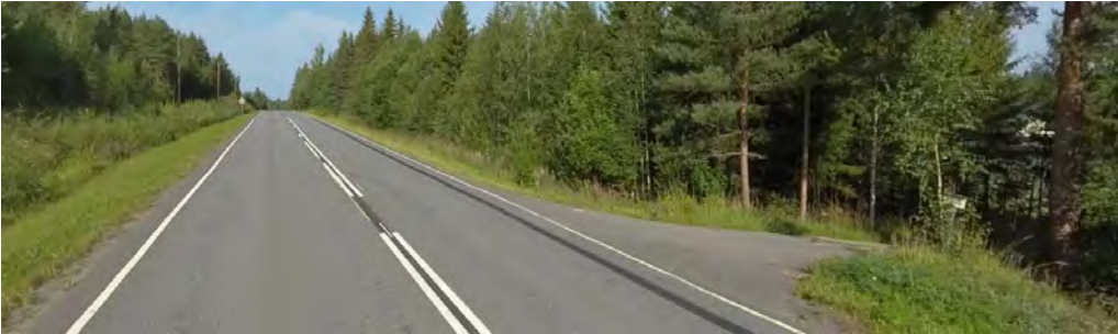
Kuva 6: Näkymä idästä länteen
