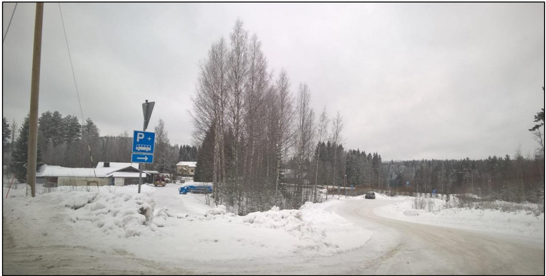
Kuva 12. Liityntäpysäköintiä valtatie 4 varrella Toivakan liittymässä.
